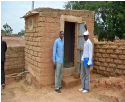
Figure 10: latrine sèche réalisée à Torodi - modèle vietnamien (Source : DJARIRI)
