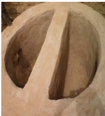
Figure 13: double fosse en banco- APA Figure 14: réalisation latrine sèche APA Figure 12: latrine sèche réalisée à Maifarou- Aguié (source: DJARIRI)
