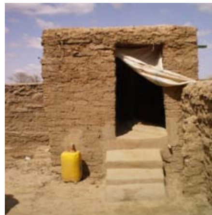
Figure 13: double fosse en banco- APA Figure 14: réalisation latrine sèche APA Figure 12: latrine sèche réalisée à Maifarou- Aguié (source: DJARIRI)
