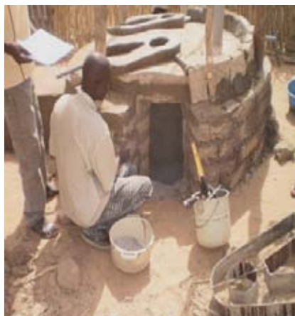
Figure 13: double fosse en banco- APA Figure 14: réalisation latrine sèche APA Figure 12: latrine sèche réalisée à Maifarou- Aguié (source: DJARIRI)
