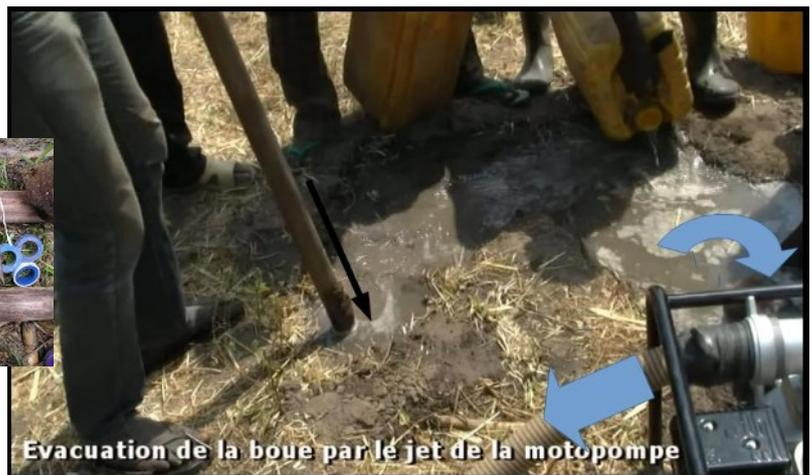
Carte des zones propices. Creusement avec un tube plus ou moins armé et extraction de l'eau avec une motopompe thermique
