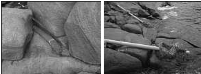
La merde venant des toilettes est évacuée directement sur le rivage par les canalisations, et gagne la mer à marée haute. Sierra Leone
