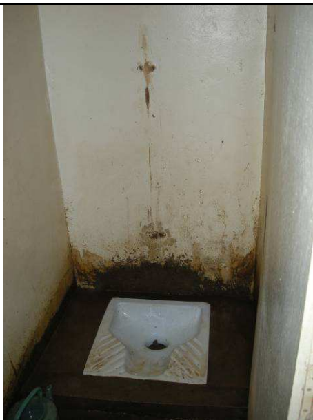
Ancienne toilette à chasse d'eau avec dalle « à la turque », dont les tuyaux ont été arrachés. Elle est désormais utilisée comme une Toilette à Chasse d'eau Manuelle (TCM). En bas à gauche un bouilloire en plastique servant au nettoyage anal. (marché de Zankare Yare)
