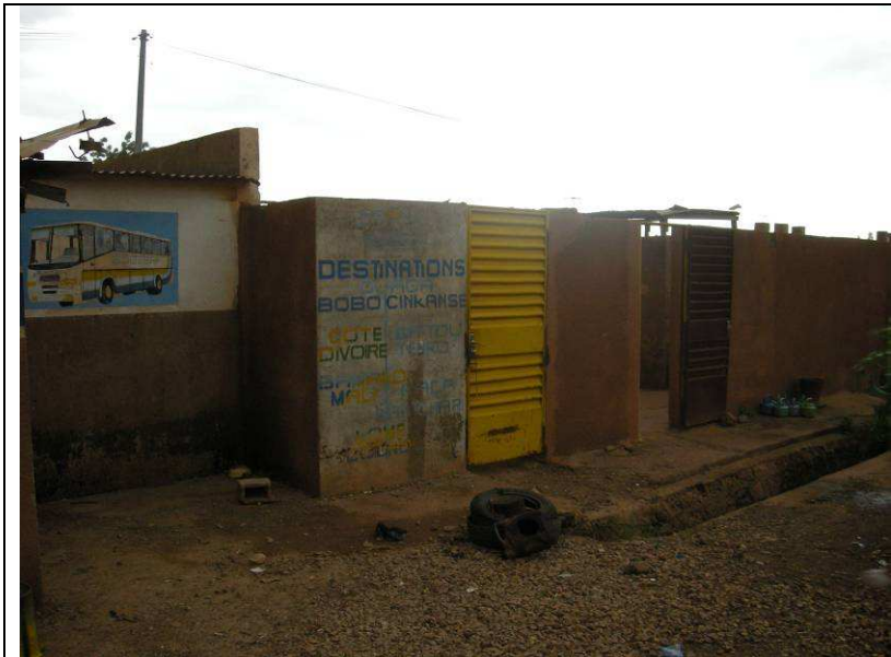
Latrines / douches publiques construites à la gare de l'Est par la société de transports de voyageurs SOGEBAF.
