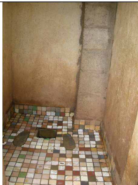
Intérieur d'une cabine VIP dont la dalle est carrelée. Notons au fond à droite la conduite permettant l'aération de la fosse. (marché de Baskuy)
