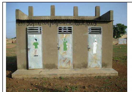
Bloc latrines au CSPS de Tenkodogo (région Centre-Est). Notons la séparation par genre et la séparation soignants – patients.
