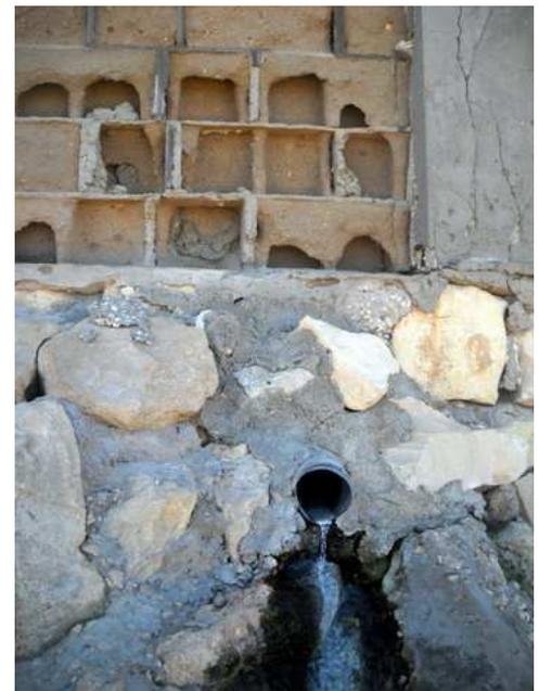
Figure 19 : Tuyau d'évacuation d'eau usée en mer de la Copefrito (RAJAONARIVELO, 2013)
