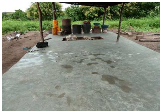
La dalle terminée (185 euros)
