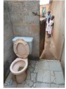
Intérieur carrelé de la cabine avec une cuvette de WC sans chasse d'eau (1,20 x 1,60 m)
