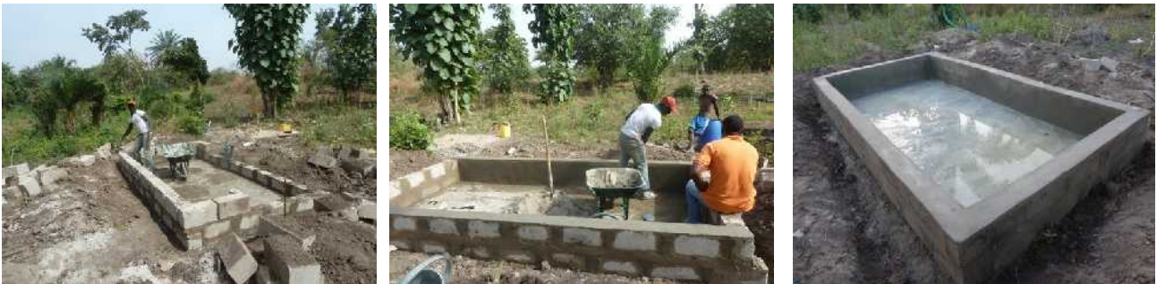
Construction du premier bassin le 16 décembre 2013 (40 cm de haut)
