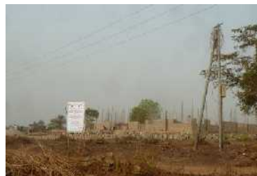
Construction du nouveau commissariat à la sortie de la ville
