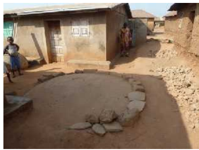
Fosse septique profonde maçonnée (au fond la cabine)
