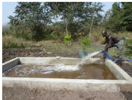
Mise en eau du 1er bassin
