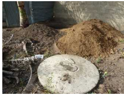
Emplacement des latrines chez Eugène Sanplat déjà fabriquée depuis longtemps Trou de 2m x 1,5 m
