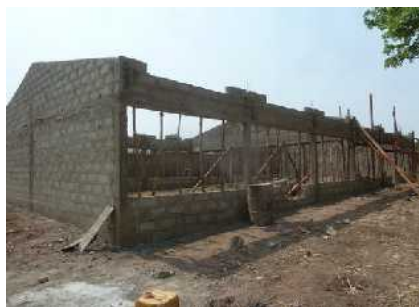
Construction d'un poulailler
