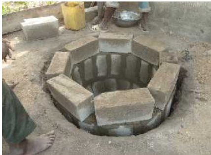
Construction de la fosse Superstructure en tôles (23 euros) Intérieur des latrines
