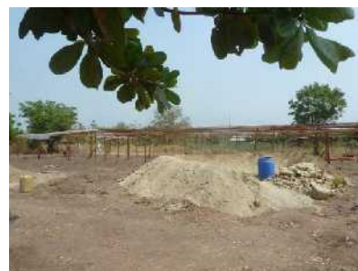
Recherche d'un point d'eau. Le creusement est arrivé à la roche
