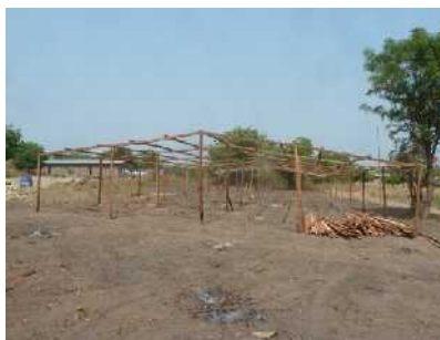
Construction d'une serre pour la culture hors sol de légumes
