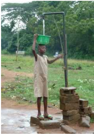
Borne fontaine en novembre 2012 à l'EPP d'Amouloko
