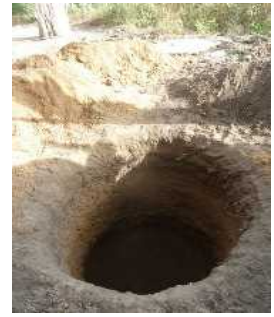
Emplacement des latrines chez Eugène Sanplat déjà fabriquée depuis longtemps Trou de 2m x 1,5 m
