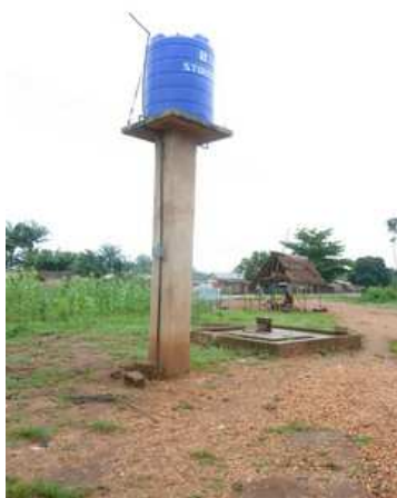
Château d'eau construit par AEV
