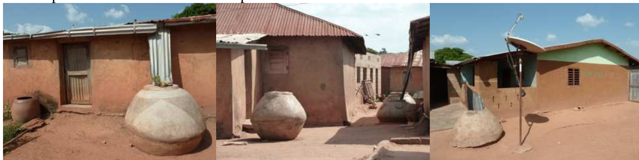
Quelques réservoirs d'eau de pluie dans le village de Vossa
