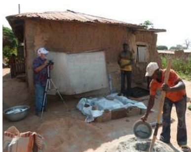
Fabrication du soubassement avec des vieilles briques et 2 sacs de riz
