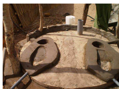
Latrines économiques faites au Niger et au Tchad (toilette sèche à 2 fosses et séparation de l'urine)
