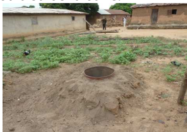
Fût enfoncé au 2/3 dans le terrain du directeur d'école. L'érosion risque de poser un problème pendant la saison des pluies
