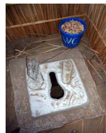
Soubassement et Sanplat
