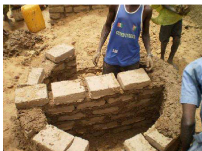
Latrines économiques faites au Niger et au Tchad (toilette sèche à 2 fosses et séparation de l'urine)
