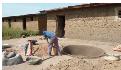
Construction d'un réservoir d'eau à Vossa (partie basse dans le sol)
