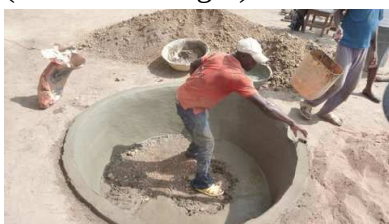
Construction d'un réservoir d'eau à Vossa (partie basse dans le sol)
