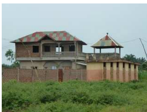
Latrines du complexe scolaire d'Amouloko
