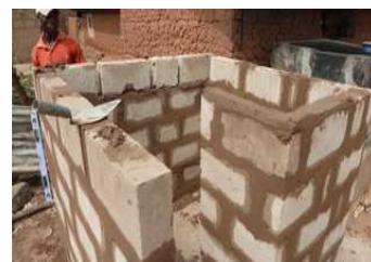
Douche en construction
