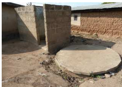
Douche avec puisard couvert d'une dalle
