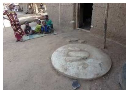
Dalle fabriquée à Ouèssè par un maçon de la ville
