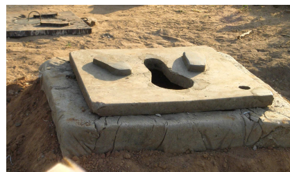
Soubassement et sanplat (« Sanitary platform ») posés sur le tonneau
