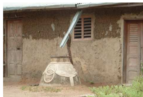
Impluviums dans la région d'Ouèssè (hors sol ou enfoncé dans le sol)
