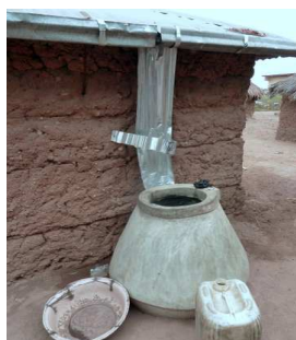
Impluviums dans la région d'Ouèssè (hors sol ou enfoncé dans le sol)
