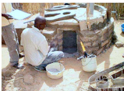
Latrines économiques faites au Niger et au Tchad (toilette sèche à 2 fosses et séparation de l'urine)
