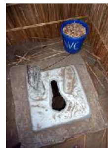
Soubassement et Sanplat
