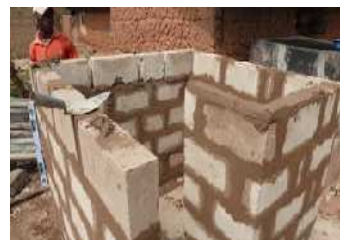
Douche en construction
