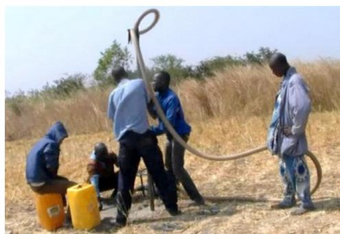
Forage avec le tube alu et la motopompe et pose du tuyau PVC (Ouessè)
