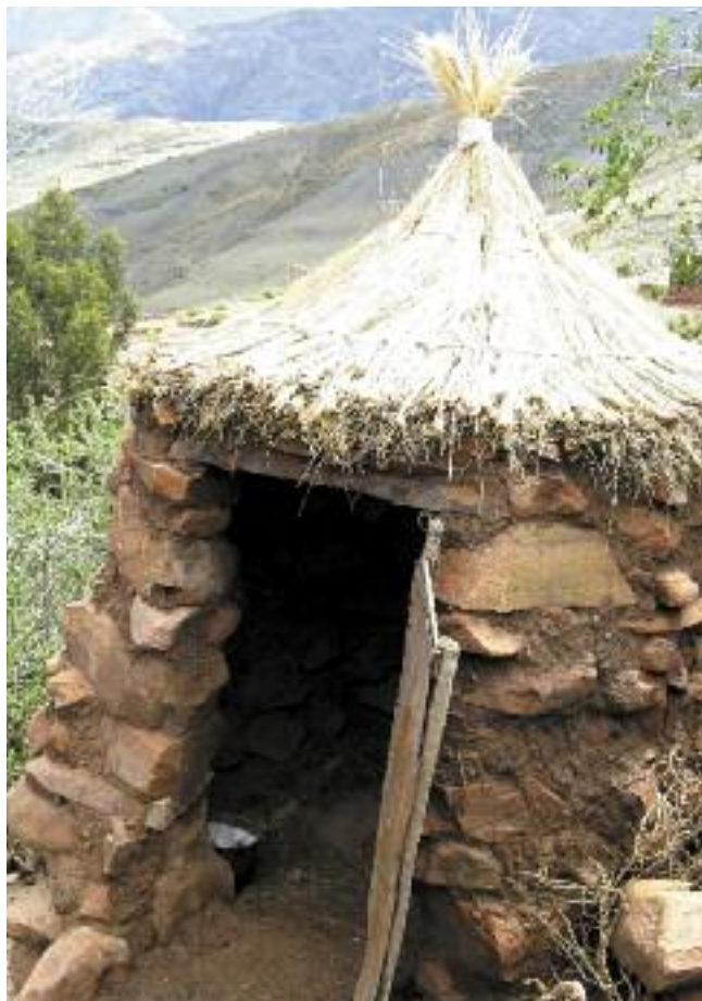
A GAUCHE ET CI-DESSUS Communautés villageoises dans les Andes en Bolivie. Utilisation de pierres et de briques en latérite pour la construction. Photo : Meghan Myles, UNICEF Bolivie.
