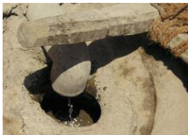
CI-DESSUS ET A GAUCHE Une communauté locale d'un village de l'Etat du Maharashtra en Inde a introduit cette méthode inédite d'absorption des eaux usées provenant de la salle d'eau par un pot perforé et enterré rempli de galets et de cailloux. Ceci a permis de maintenir la route sèche et propre alors qu'auparavant elle était boueuse et sale.
