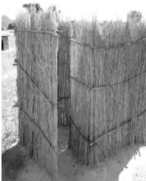
Latrine à fosse réalisée à partir de matériaux locaux.
