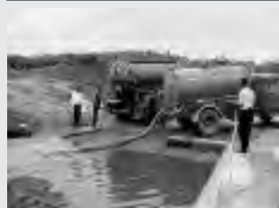
8. Site de dépotage de boues de vidange
