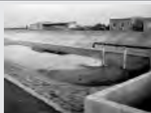
9. Bassin de lagunage
