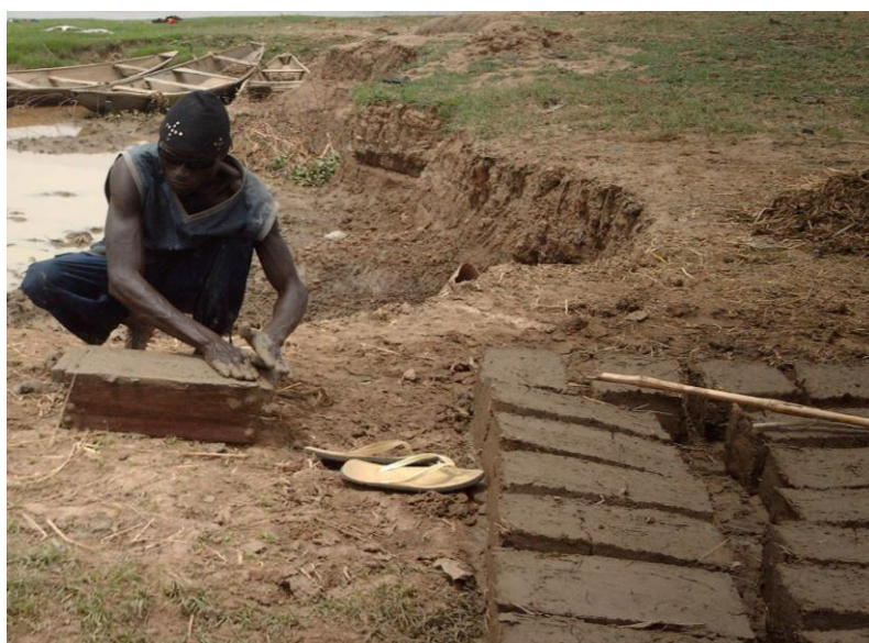
Photo n° 13: Site fabrication des agglos la ville de Malanville ; Prise de vue : A. ALOMASSO, juin 2013
