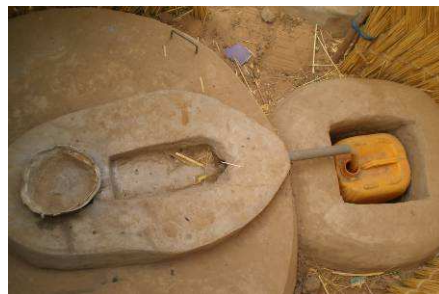
La latrine à compost (Fossa alterna) avec séparation d'urine
